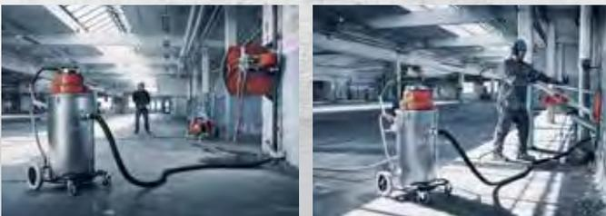
L'eau d'arrosage lie la poussière directement à la source. Le collecteur raccordé à un aspirateur de boue permet de garder le chantier propre.
