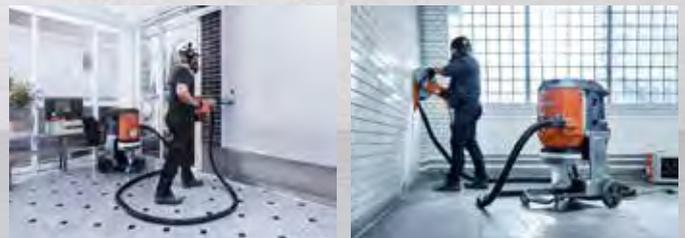
Avec un dispositif anti-poussière intégré, la poussière produite en découpant/forant à sec est captée à la source. Un extracteur de poussière correctement dimensionné et pourvu d'un filtre HEPA H13 prend absorbe la poussière. L'air environnant est filtré au moins 6 à 10 fois/heure par un purificateur d'air portatif.
