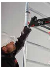
Des 'mains supplémentaires' pour accrocher du matériel pendant le montage et le démontage du MiTOWER. Se plie et se déplie en un seul mouvement.
